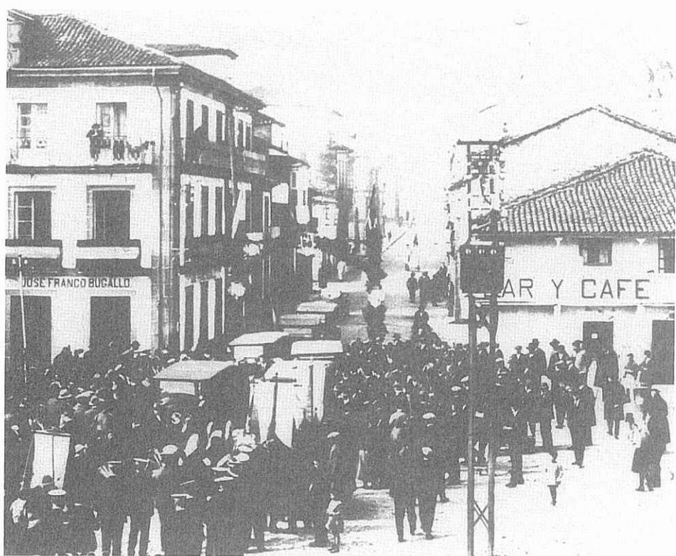
7- Praza de Ramiro Ciorraga (hoxe praza de Galicia) donde se aprecia un transformador eléctrico montado sobre un castelete de ferro. Foi trasladado no 1.925 á rúa Justo Martínez donde se instalou nunha caseta de cemento.
